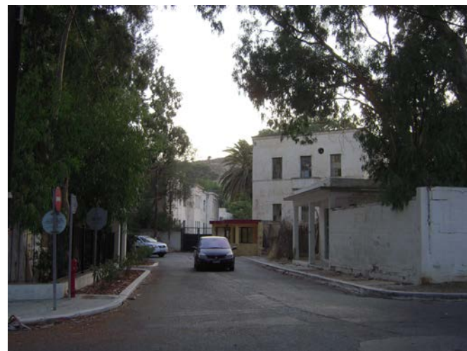
Εικ. 27. Κρατικό Θεραπευτήριο Λέρου, πρώην Εγκαταστάσεις γυναικών στο Λακκί (φωτ. Γκράτσου Γεωργία, Αύγουστος, 2013)
