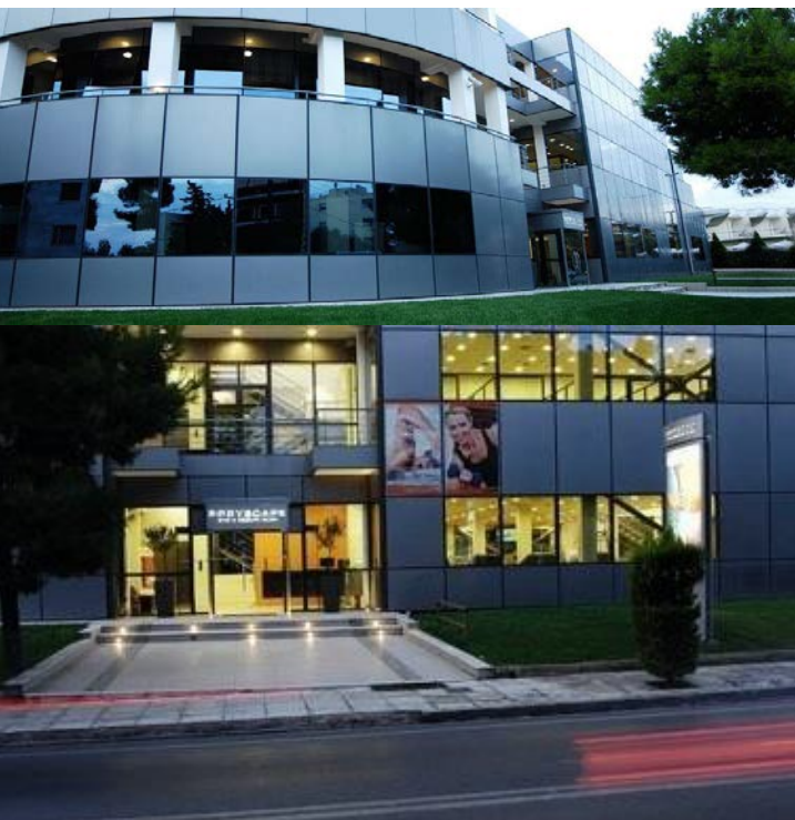
Όψη από το δρόμο
