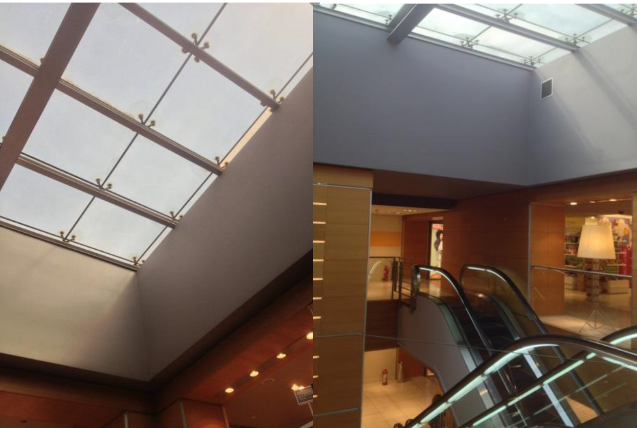
Το φως στο πολυκατάστημα, εισέρχεται στα κλιμακοστάσια από την οροφή
