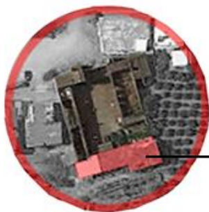
τμήμα μετοχιού που έχει γκρεμιστεί
