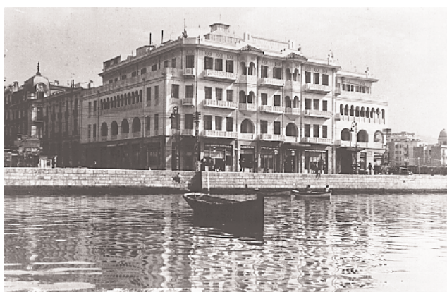
Το ξενοδοχείο Mediterranean Palace κατεδαφίστηκε στο σεισμό
