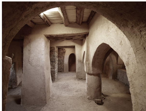
Εικ. 75: Εσωτερική άποψη κτίσματος
