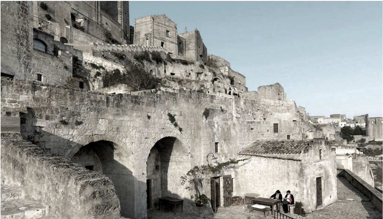
Εικ. 64: Άποψη μέσα στον οικισμό
