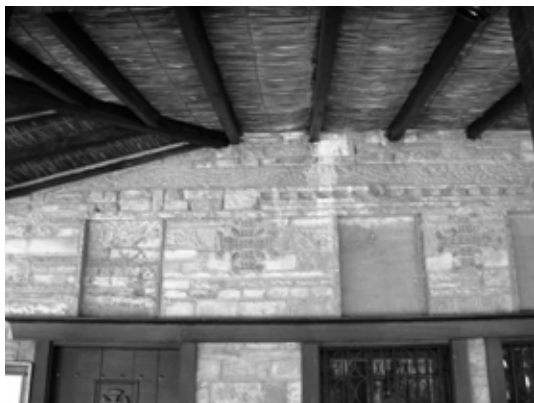
εικ.20 Λεπτομέρεια στέγασης ημιυπαίθριου χώρου.
