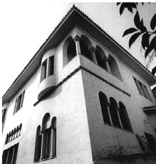
εικ.2 Άποψη της οικίας και εξώστης.
