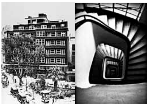
εικ.27/28 Κ.Παναγιωτάκος, Μπλε πολυκατοικία, άποψη και εσωτερική σκάλα, Αθήνα, 1932-33.
