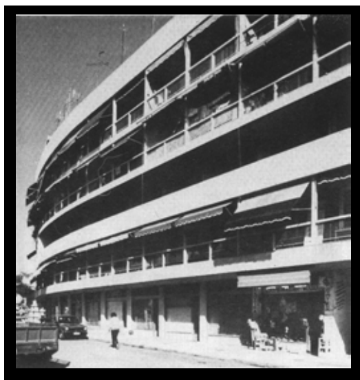
εικ.54 Αποψη από την μεριά της γειτονίας. Καταστήματα, διαμερίσματα και ο εξώστης στον δεύτερο όροφο.
