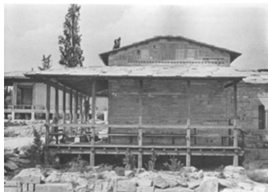
εικ.17 Ξύλινη κατασκευή στέγαστρου ναού.
