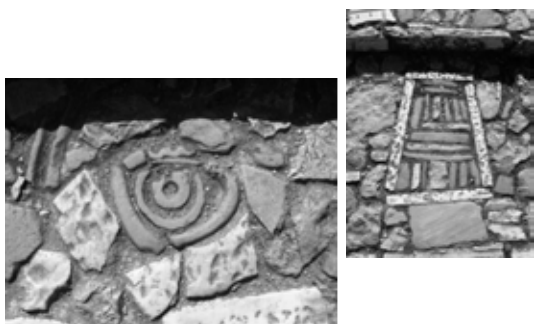
εικ.22 Λεπτομέρειες πλακόστρωτου.
