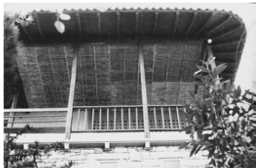
εικ.45 Λεπτομέρεια εξώστη. Ξύλινα δοκάρια «φέρουν» πλάκα σκυροδέματος στο ισόγειο ενώ στον όροφο η πηλιορείτικη ξύλινη στέγη συνδυάζει «γραφικές» καμπυλώσεις με εξωτικές ψάθες.
