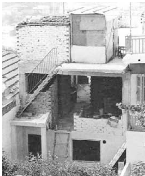
εικ.37 Σταδιακή κατασκευή κατοικίας.
