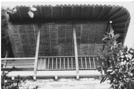
ΕΙΚ.12 Λεπτομέρεια εξώστη. Ξύλινα δοκάρια «φέρουν» πλάκα σκυροδέματος στο ισόγειο ενώ στον όροφο η πηλιορείτικη ξύλινη στέγη συνδυάζει «γραφικές» καμπυλώσεις με εξωτικές ψάθες.
