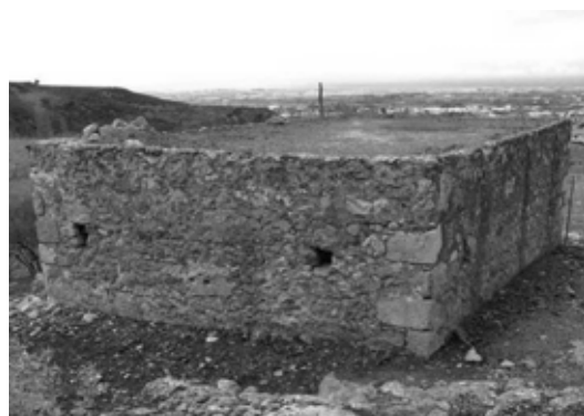
εικ.41 Κατοικία στο Κυπαρίσσι Λακωνίας.
