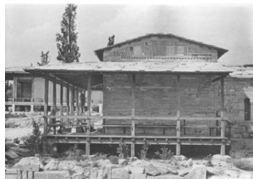
ΕΙΚ.97 Ξύλινη κατασκευή στέγαστρου του Αγίου Δημήτριου, στο Λουμπαρδιάρη.
