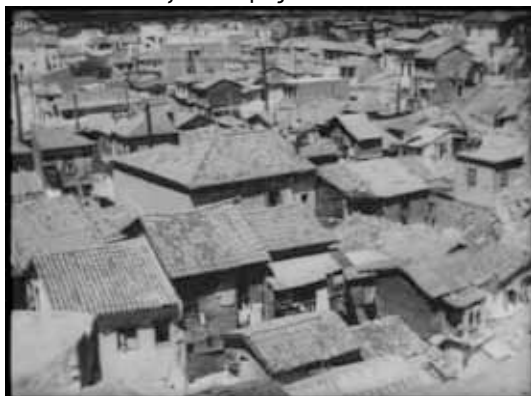
εικ.44 Ασύρματος δεκαετία '60.
