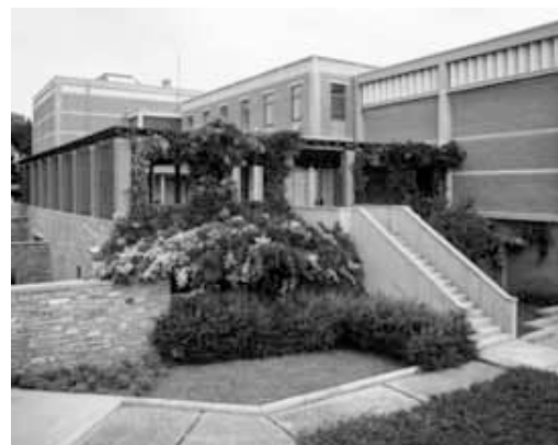
ΕΙΚ.99 ΜΒΠ, εξωτερική άποψη αναψυκτηρίου.
