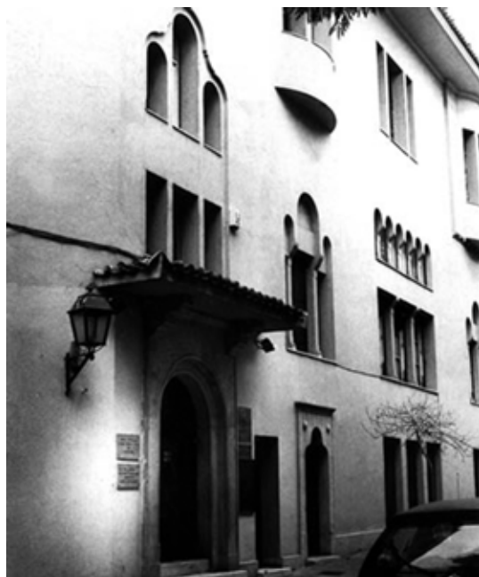
εικ.1 Όψη οικίας επί της οδού Χατζημιχάλη.
