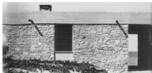
εικ.36 Τμήμα βόρειας όψης.
