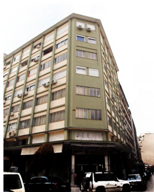
εικόνα 15: κτίριο Α' Λεοντος Σοφού - Βαλαωρίτου
