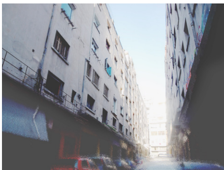
εικόνα 17: κτίριο Γ' διδυμα κτίρια οδού Ερνέστ Εμπράρ
