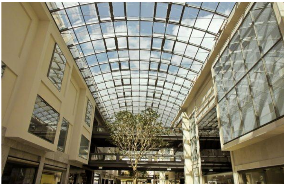
Εικ. 5.8. Τα πρωτεύοντα και δευτερεύοντα δομικά στοιχεία της οροφής στεγασμένου αιθρίου.
