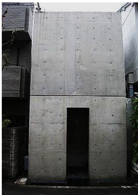
Εικ. 4.5. Tadao Ando - Azuma House (1976). Όψη στο δρόμο.
