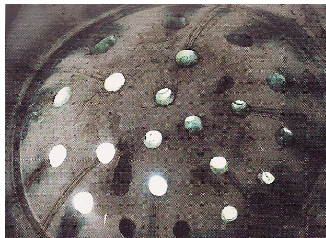
Εικ.46: Φωτιστικές οπες σε τρούλο. Βυζαντινός Λουτήρας στην Κω. (πηγή: Ελένη Κανετάκη, Οθωμανικά Λουτρά στον Ελλαδικό Χώρο, σελ. 311
