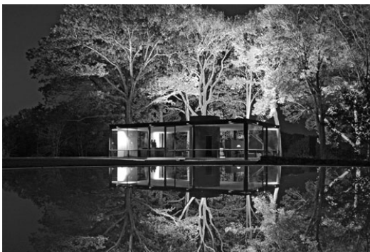
εικόνα 65. Glass house, Philip Johnson, Connecticut, 1949
