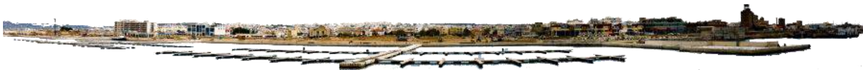
Το παραλιακό μέτωπο της πρώην βιομηχανικής ζώνης «Κόβα»
