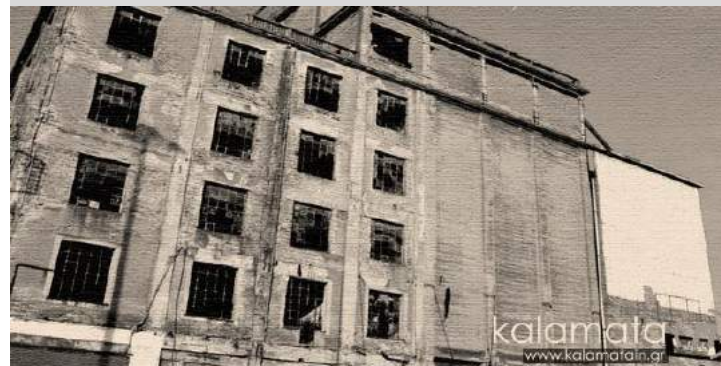
Σημερινή κατάσταση κελύφους Πηγή : ιστότοπος kalamatain.gr
