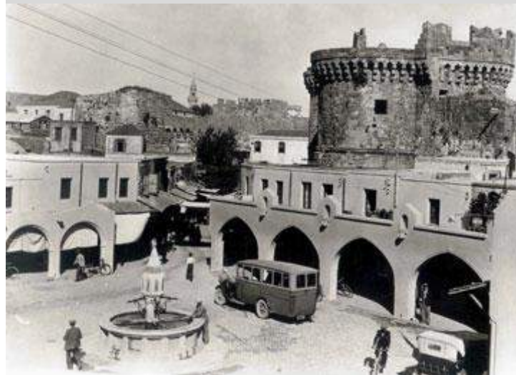
Άποψη της Πλατείας του Πυρός, 1929-30
