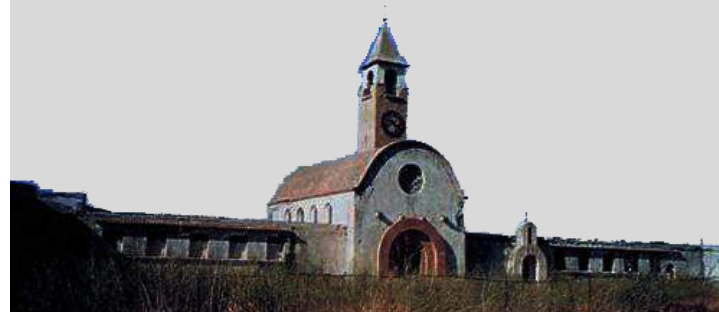
Μια άποψη του συγκροτήματος στην Καταβιά Αρχείο: Β. Κολώνας, «Ιταλική αρχιτεκτονική στα Δωδεκάνησα. 1912-1943» εκδ. Ολκός, Αθήνα, 2002
