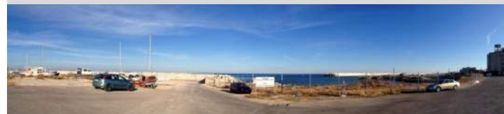
Παραλιακό μέτωπο_ απέραντο εργοτάξιο Πηγή : προσωπικό αρχείο
