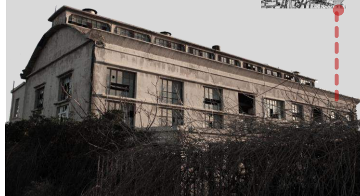
Σημερινή άποψη του κτηρίου της ΔΕΗ στην οδό Αυστραλίας Πηγή: Προσωπικό αρχείο
