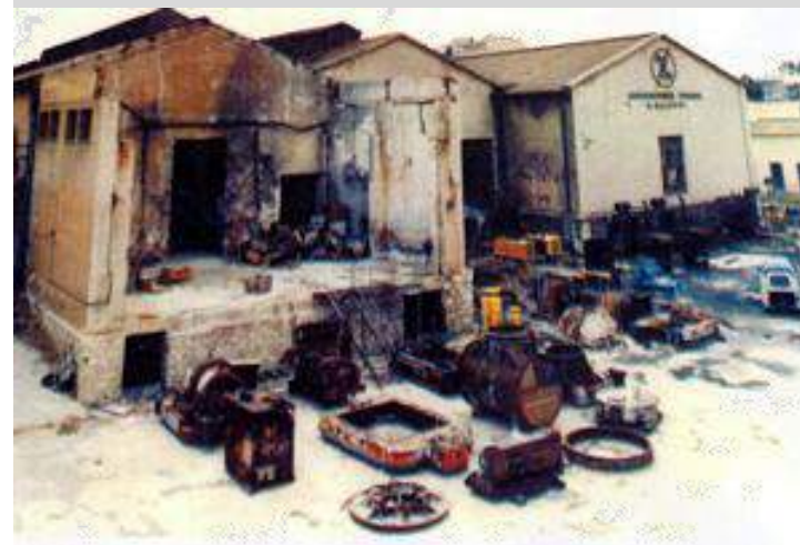
Ατμοηλεκτρικός σταθμός Νέου Φαλήρου
