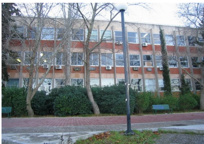
Εικόνα 4.9, Βόρεια πλευρά που φαίνονται τα κατακόρυφα σκίαστρα από μπετόν
