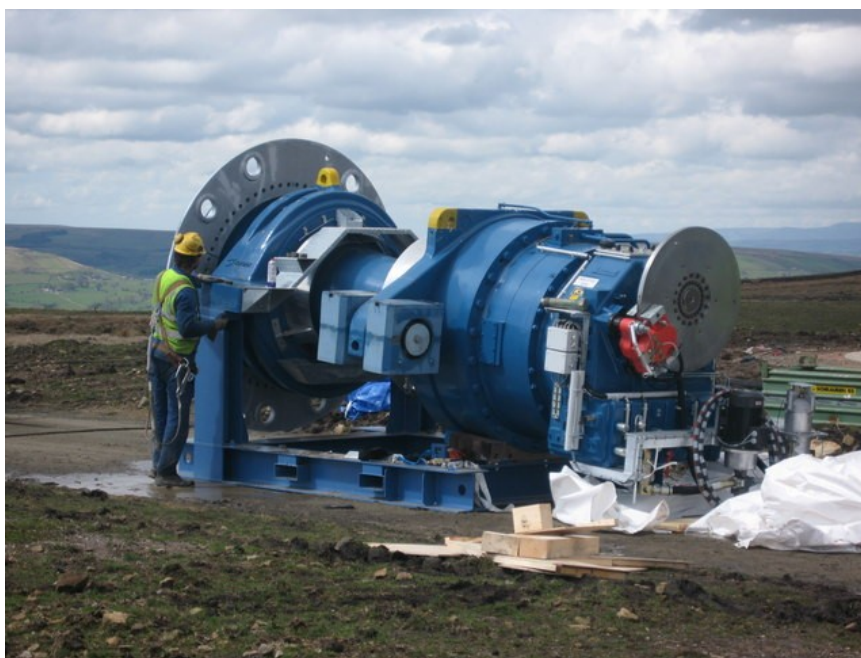
Εικόνα 1.5, Μετατροπέας στροφών και γεννήτρια ανεμογεννήτριας οριζοντίου άξονα (Πηγή: www.geograph.co.uk )
