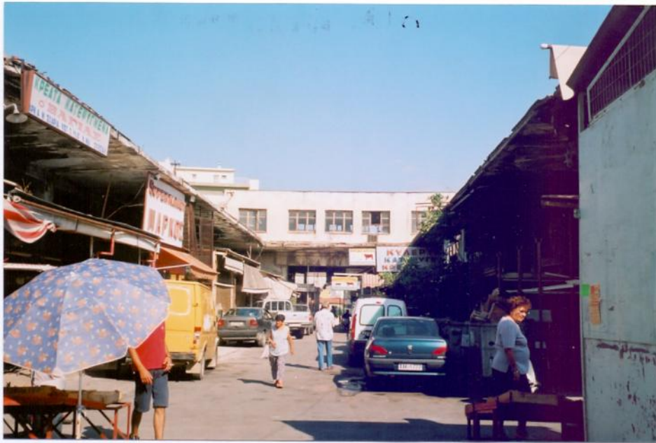
Εσωτερικός διάδρομος με απαράδεκτη χρήση στάθμευσης οχημάτων. Στο βάθος το κτήριο του Μεσοπολέμου με εμφανή τα μορφολογικά στοιχεία του Μοντέρνου Κινήματος
