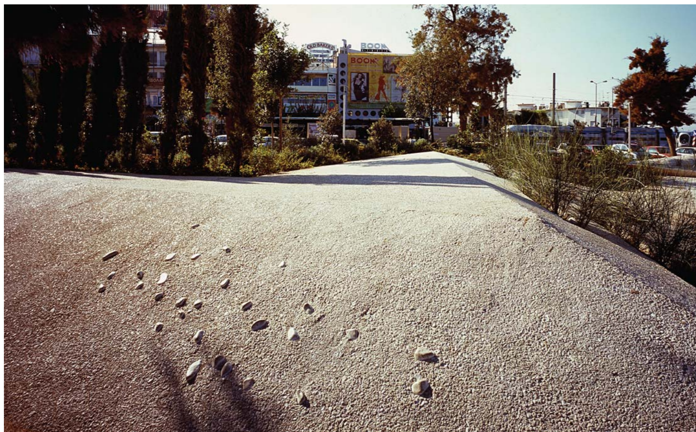
ΕΙΚΟΝΑ 13: Το béton lavé ως τεχνητός ιζηματογενής βράχος, στην πλατεία Κατράκη. Αντί απολιθωμάτων ενέχει βότσαλα που αναφέρονται στην γειτονική παραλία στον Σαρωνικό. Φωτό: Ε. Αττάλη
