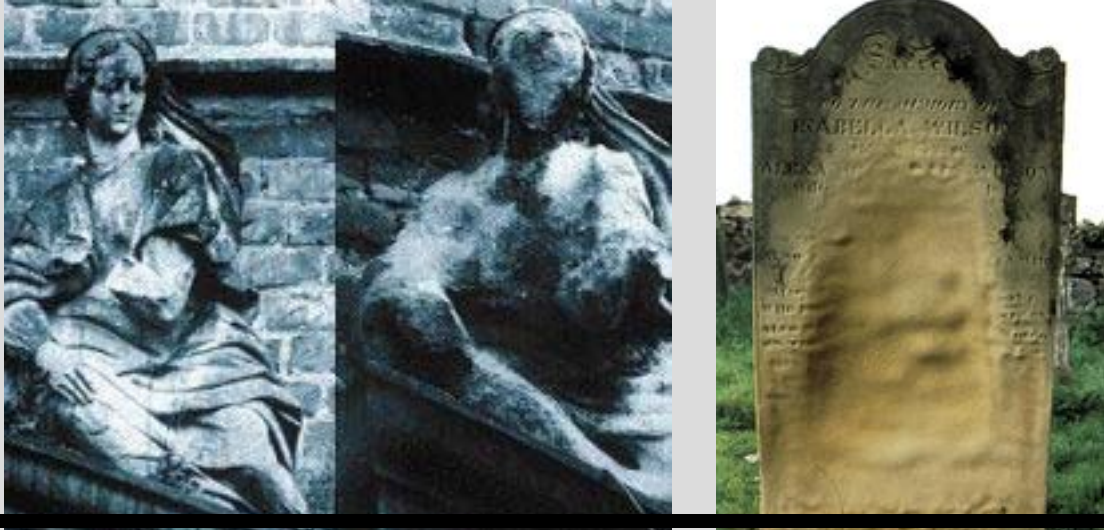
Εικόνα 9 Διάβρωση από όξινα αποθέματα
