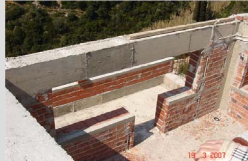
Εικόνα 86 Η εξωτερική τοιχοποιία: α) μόνωση β) αύξηση εσωτερικής μάζας
