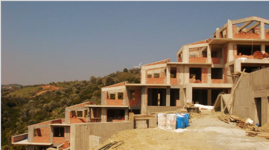
Εικόνα 84 Η φάση κατασκευής που βρίσκεται σήμερα
