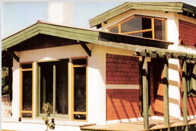
Εικόνα 54 Εξωτερική όψη τοίχων Trombe
