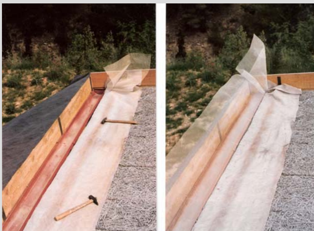
Εικόνα 72 Κατασκευή φυτεμένης στέγης
