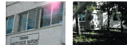
_Εξωτερική φωτογράφιση μεθόδων σκίασης
