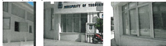
_Εξωτερική φωτογράφιση μεθόδων σκίασης
