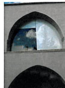
_Εξωτερική φωτογράφιση μεθόδων σκίασης
