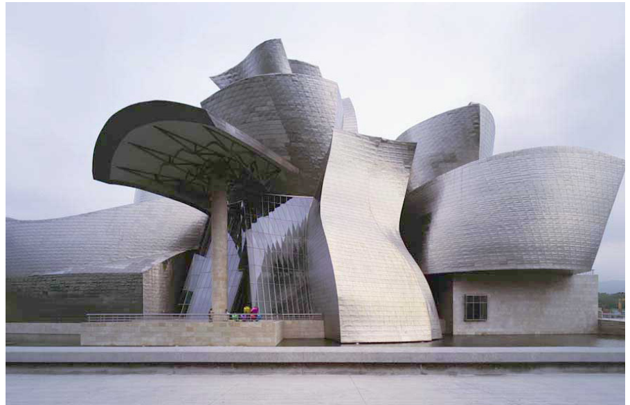
εικ. 57: Guggenheim Bilbao | F. Gehry
