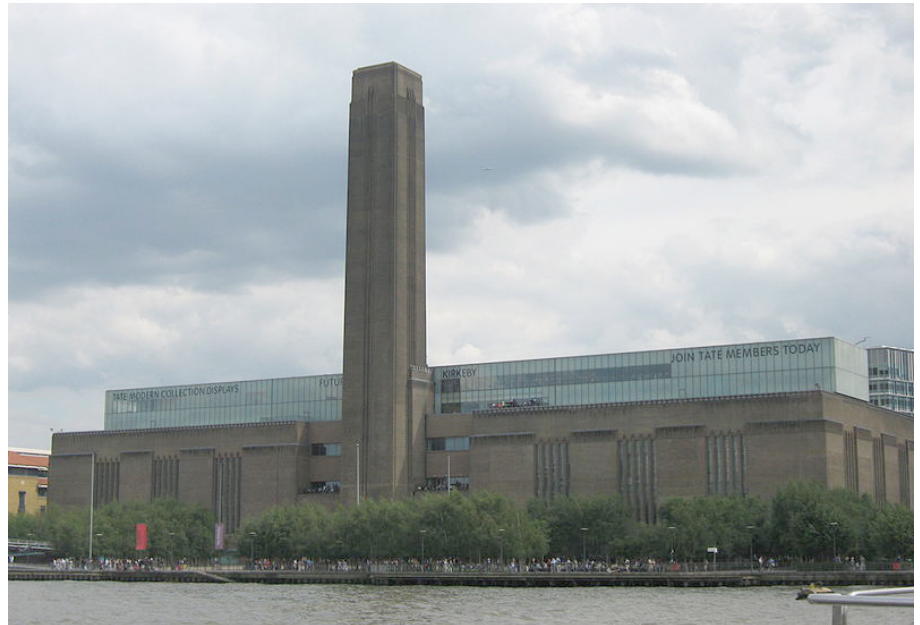
εικ. 47: Tate Modern, Λονδίνο (σταθμός παραγωγής ενέργειας)
