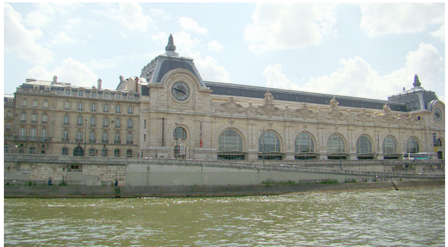
εικ. 48: Musée d'Orsay, Παρίσι (κεντρικός σιδηροδρομικός σταθμός)
