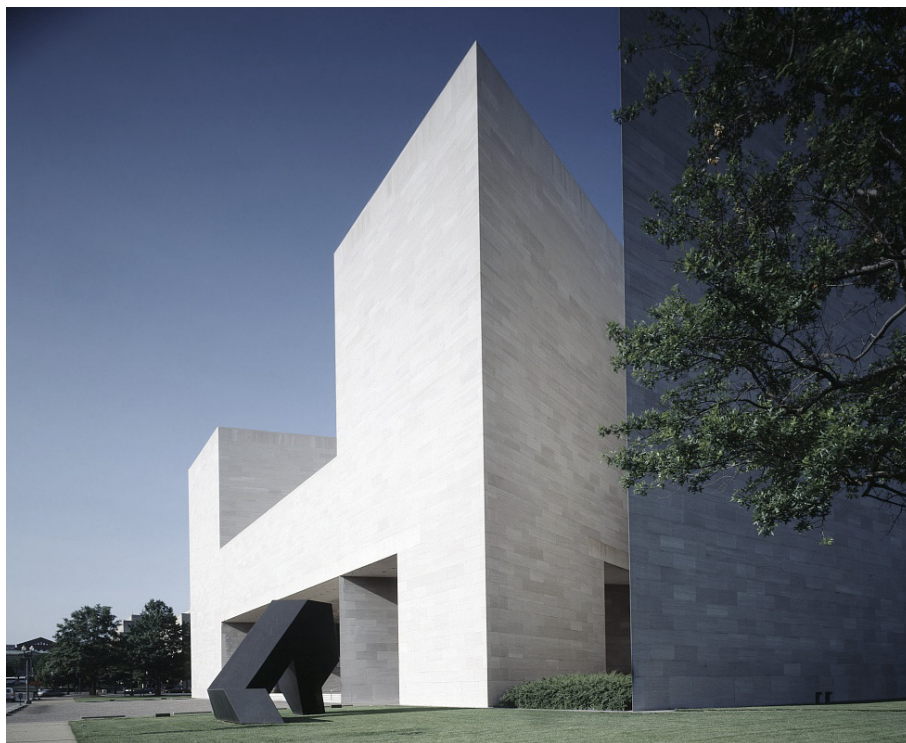
εικ. 42: νέα πτέρυγα Εθνικής Πινακοθήκης, Ουάσινγκτον
