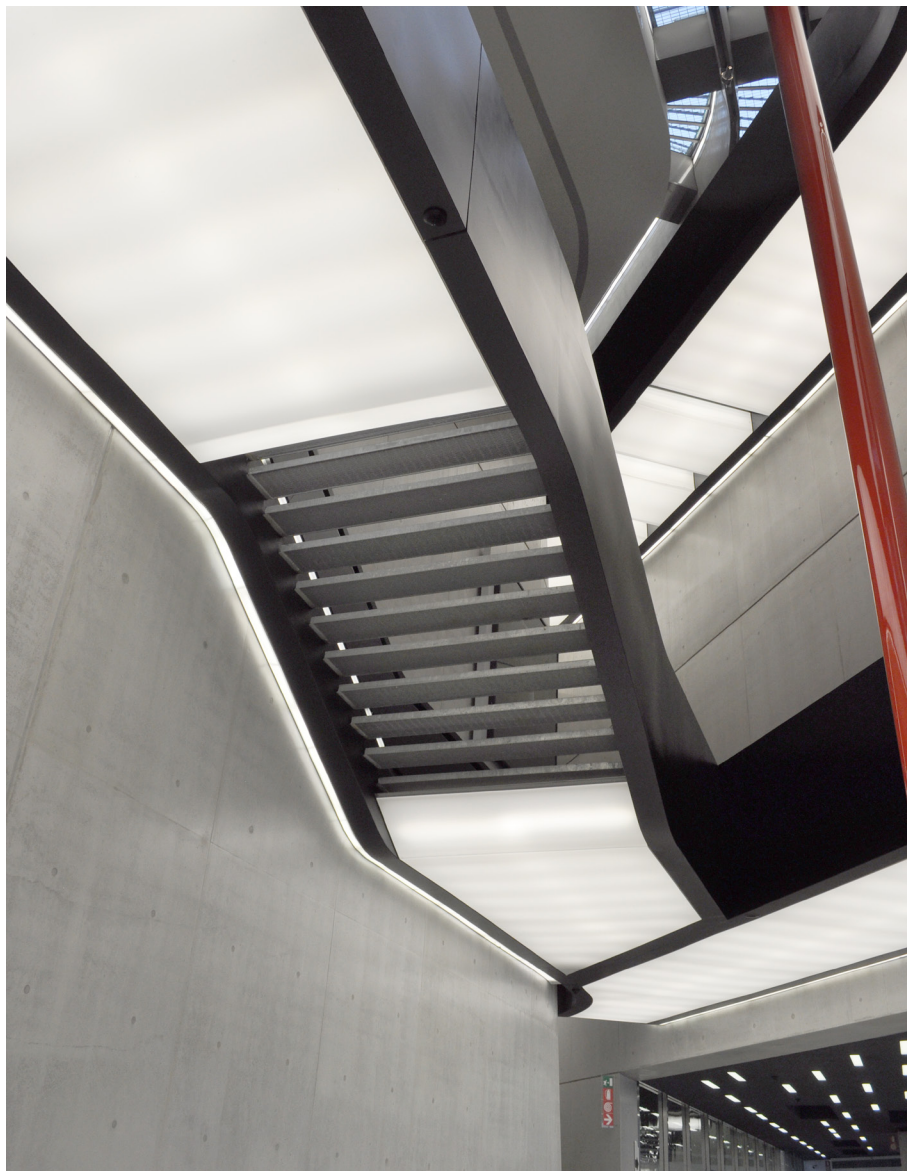
εικ. 60: η μορφή του κεντρικού κλιμακοστασίου
