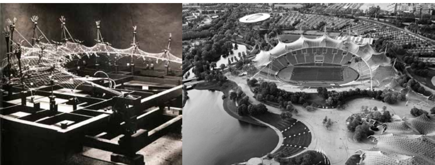
Πρόπλασμα της στατικής μελέτης και αεροφωτογραφία του Ολυμπιακού Σταδίου του Μονάχου.
