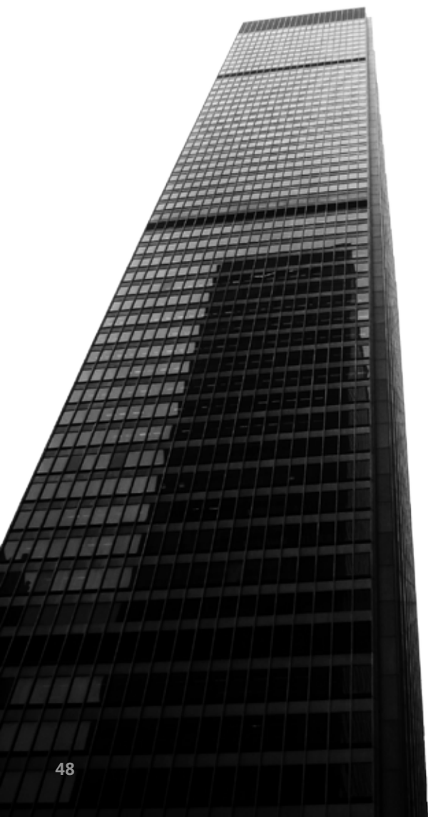
Τα γραφεία της Chase Manhattan, του γραφείου SOM. Νέα Υόρκη, 1963. δίπλα: αεροδρόμιο Dulles, Eero Saarinen. Πολιτεία Virginia- ΗΠΑ, 1962.
