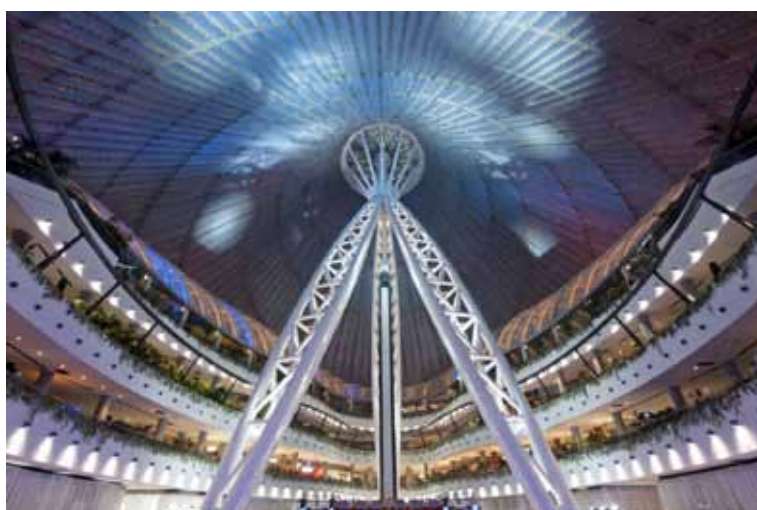
από πάνω προς τα κάτω: μακέτες εργασίας, εξωτερική άποψη και λεπτομέρεια κατά την κατασκευή, εσωτερική άποψη του Khan Shatyr
