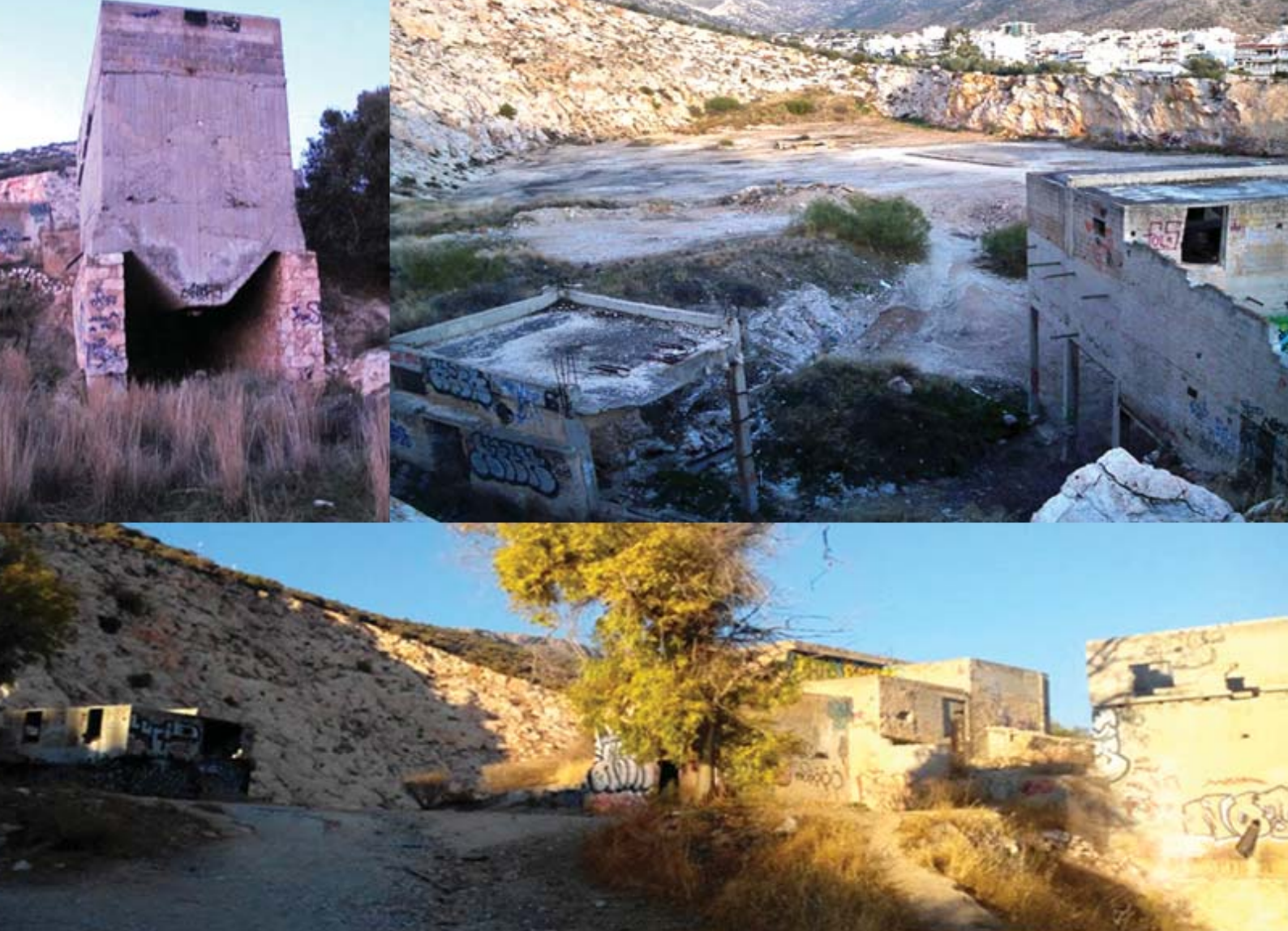
Εικόνα 155: Εναπομείναντα κτίρια στο λατομείο Άνω Γλυφάδας. (Πηγή: http://www.panoramio.com/ .)
