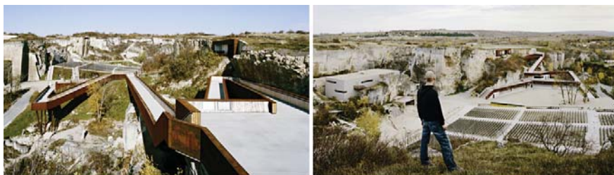
Εικόνα 64: Αναδρομή στο στοιχείο του θεάτρου, που είναι ο προορισμός και το οπτικό κίνητρο που καλεί τον επισκέπτη να το επισκεφθεί, σε όλη του τη διαδρομή προς αυτό. Η διαδρομή, αποτελεί στην επέμβαση του αρχιτέκτονα Alles Wird Gut στο ρωμαϊκό πρώην λατομείο, κατά το 2008 στην Αυστρία. (Πηγή: Η ίδια με την παραπάνω παράγραφο.)
