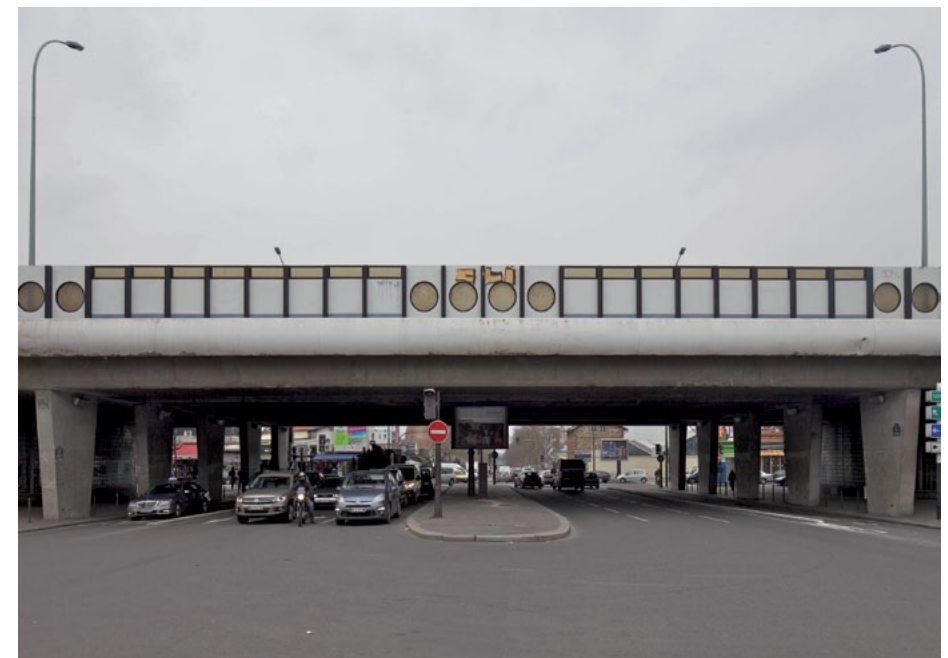
Εικ.44: Ο Περιφερειακός Αυτοκινητόδρομος ΙΙ
