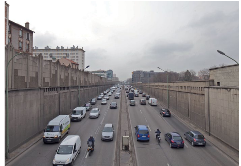
Εικ.43: Ο Περιφερειακός Αυτοκινητόδρομος Ι
