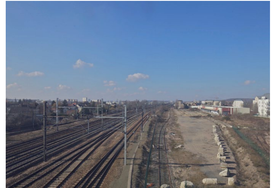
Εικ.34: Υποδομές σιδηροδρομικών γραμμών στη μητροπολιτική έκταση του Παρισιού I
