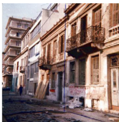
Φωτογραφία της οδού 1986, πηγή : estia.minenv.gr
