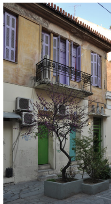
Ανακαινισμένο νεοκλασικό από τη δράση της ΚΜ Πρότυπη Γειτονιά, που λειτουργεί ως οίκος ανοχής.
