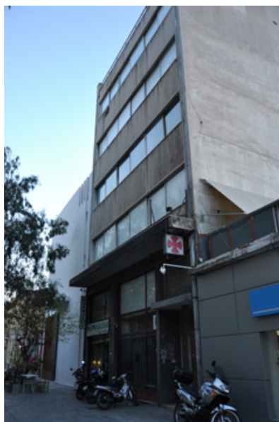
Εγκαταλελειμμένο βιομηχανικό κτίριο επί της οδού κοντά στη Λεωφόρο Αχιλλέως
