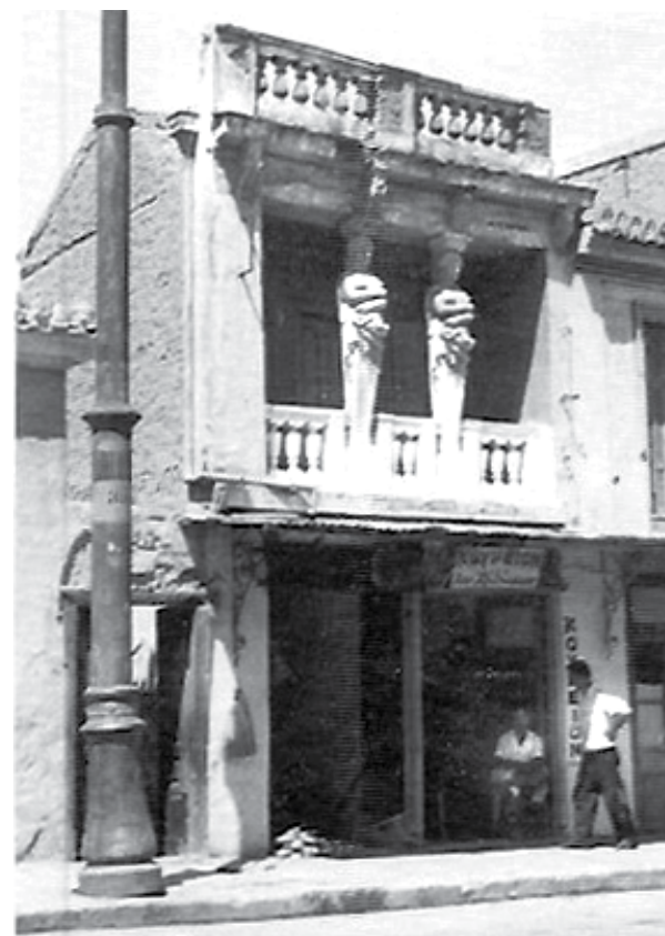
εικόνα 27: όψη κτιρίου με τις ψευτοκαριάτιδες του Ερνέστου Τσίλλερ
