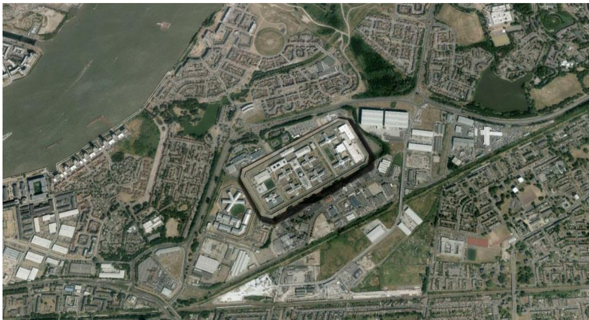
Εικόνα 3: Αεροφωτογραφία της φυλακής Belmarsh στην περιοχή London, UK.
