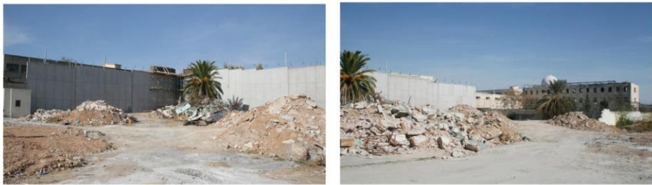
Κατεδάφιση Α΄ Πτέρυγας Γυναικείων Φυλακών
