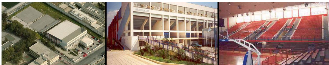
Εικόνα 45: Προοπτικό του κλειστού γυμναστηρίου Κορυδαλλού (αριστερά), η όψη του (κέντρο), το εσωτερικό του (δεξιά).
