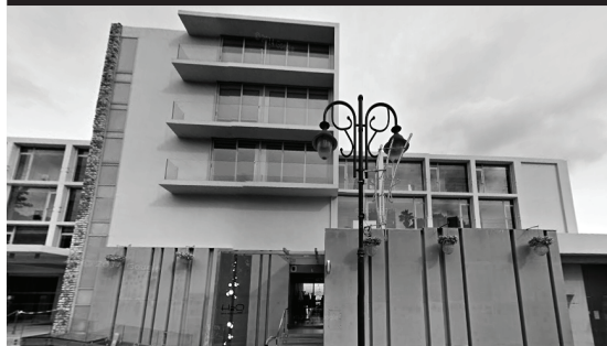
εικόνα _ 92 σημερινή κατάσταση
