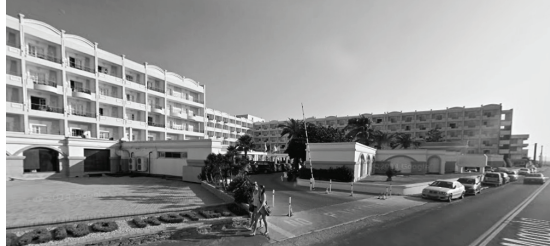
εικόνα _ 100 Η σημερινή κατάσταση του κτιρίου
