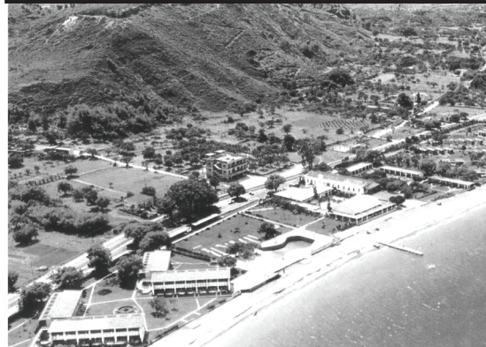
εικόνα _ 72 το κτιριακό συγκρότημα
