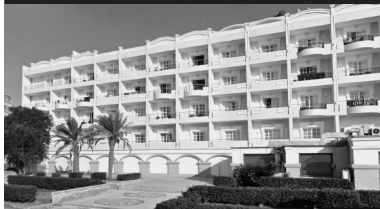
εικόνα _ 101 Η σημερινή κατάσταση του κτιρίου
