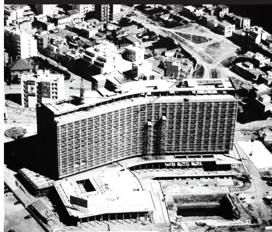
εικόνα _ 25 Ξενοδοχείο Hilton, υπό κατασκευή
