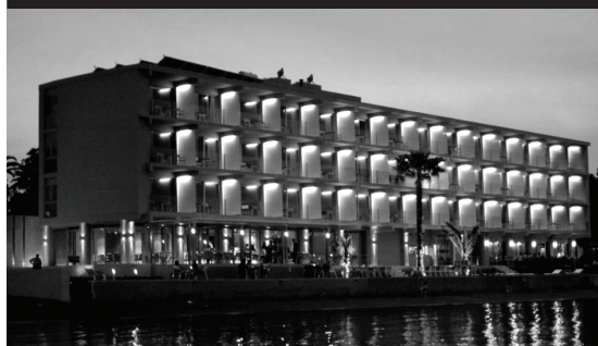
εικόνα _ 91 σημερινή κατάσταση
