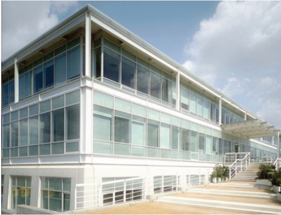
3.89 ένα από τα τρία κτίρια γραφείων της εταιρίας SOM στο Stockley park, 1988-1990
