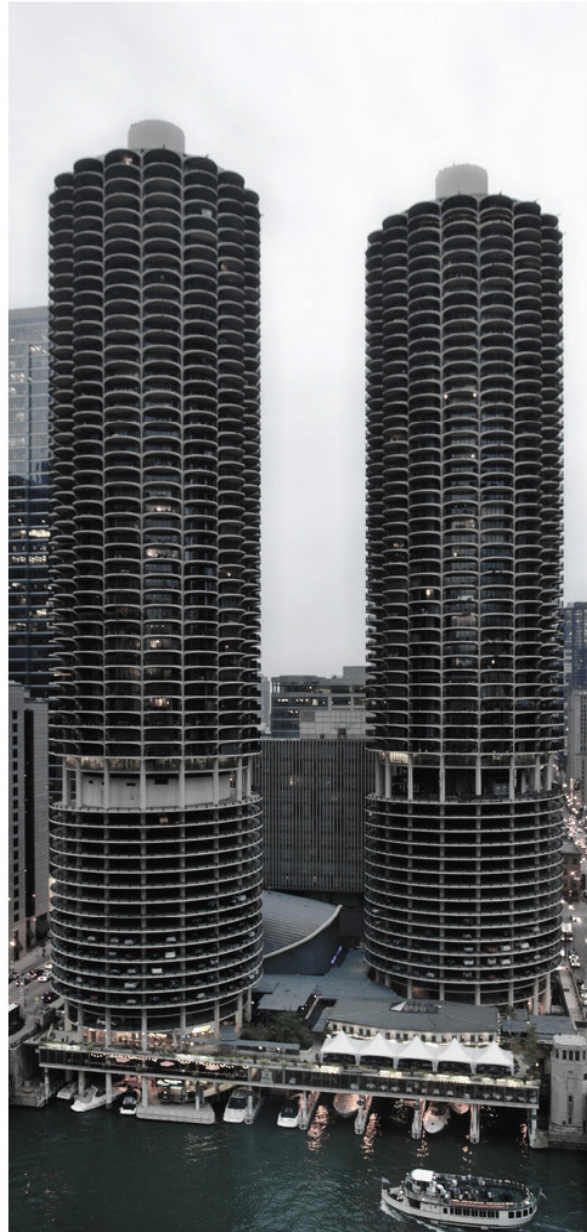
3.101 το σ'θμπλεγμα Marine City περιλαμβάνει στις κατώτερες στάθμες των πύργων της θέσεις στάθμευσης και στις ανώτερες χώρους γραφείων και κατοικιών, Bertram Goldberg, Σικάγο, 1960-1967
