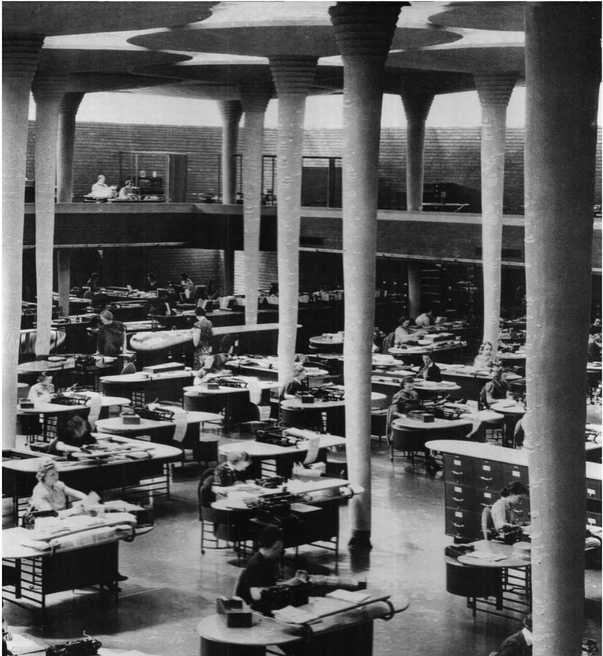
3.68 η κεντρική αίθουσα του κτιρίου (The Great Workroom) Johnson Wax Administration Building, Frank Lloyd Wright, Ουισκόνσιν, 1936-1939
