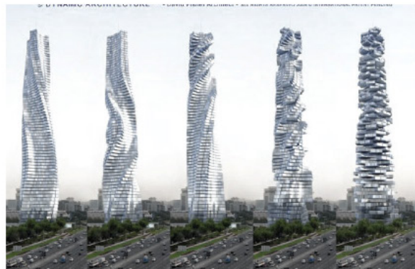
3.108 ο ουρανοξύστης Dynamic Tower, θα μετασχηματίζεται διαρκώς καθώς οι διαφορετικοί ορόφοι, που θα φιλοξενούν, ανά ομάδες, διαφορετικές προγραμματικές χρήσεις, David Fisher, Ντουμπάι, 2008
