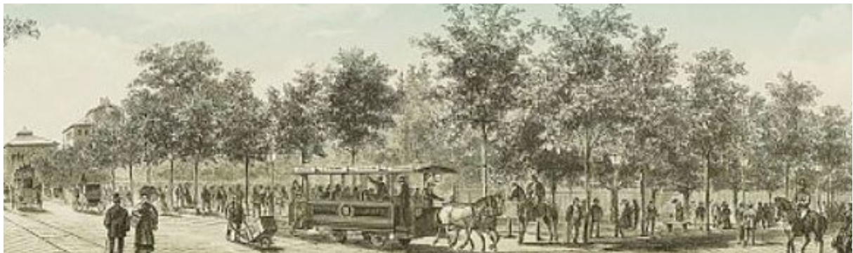
Εικ. 2.2.23. Άποψη της Ringstraße στο ύψος του τμήματος Park-Ring
