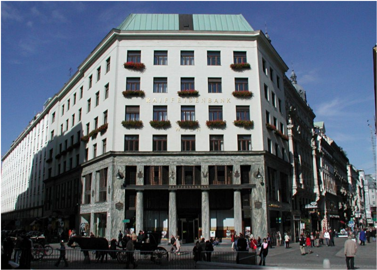
Εικ. 2.2.66. Το κτίριο του οίκου ανδρικής μόδας Goldman & Salatsch στη Michaelerplatz της Βιέννης ήταν το πρώτο κτίριο τον Adolf Loos (1909-1911)
