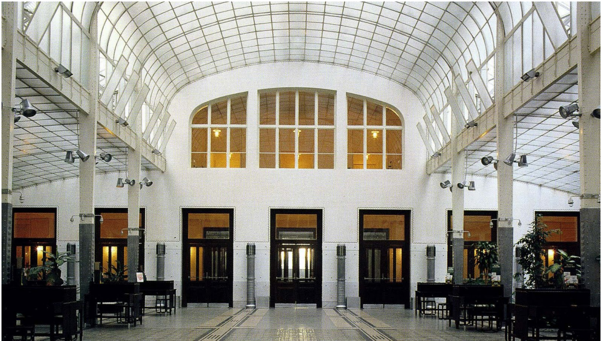
Εικ. 2.2.57. Εσωτερικό του Αυτοκρατορικού Ταχυδρομικού Ταμειυτηρίου. Η οροφή της αίθουσας συναλλαγών, από γυαλί και μέταλλο, και το γυάλινο δάπεδο που επιτρέπει να φωτίζεται το υπόγειο, επηρέασαν καθοριστικά πολλά μεταγενέστερα μοντέρνα έργα.
