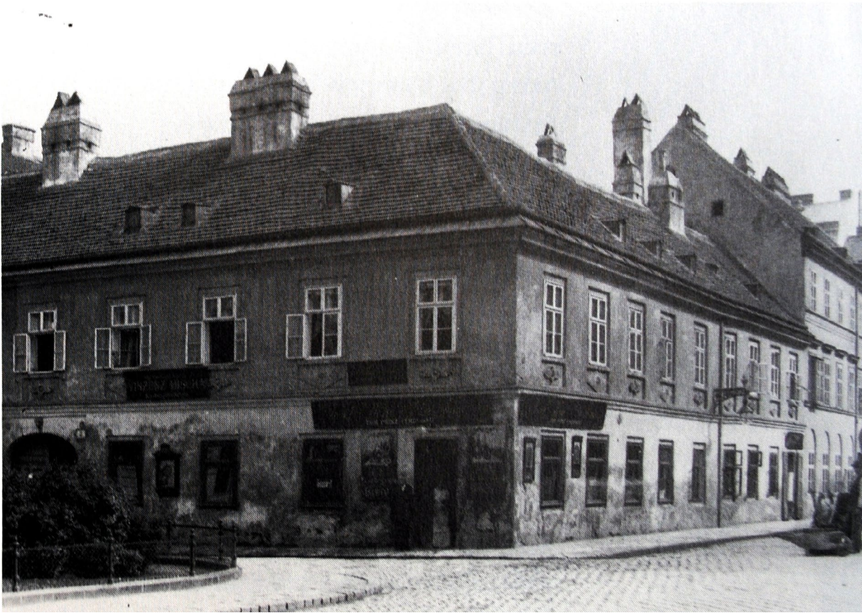
Εικ. 2.1.27. Εργατική κατοικία του 1 ου του 19 ου στην πλατεία Bennoplatz, φωτογραφία του 1904
