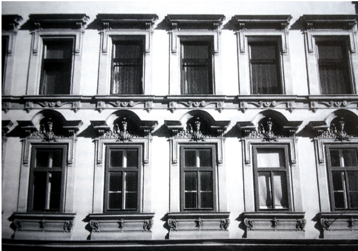
Εικ. 2.2.47. Όψη εργατικών κατοικιών Haberlgasse, φωτογραφία του 1997
