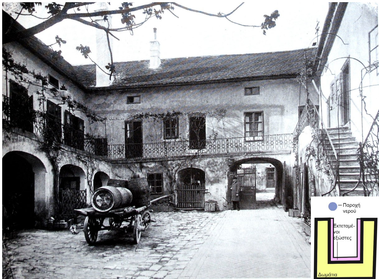
Εικ. 2.2.43. Pawlatschenhaus στην Ottakringerstraße, φωτογραφία του 1900 στο εσωτερικό Ραδwlatchen κατοικία την αυλής
