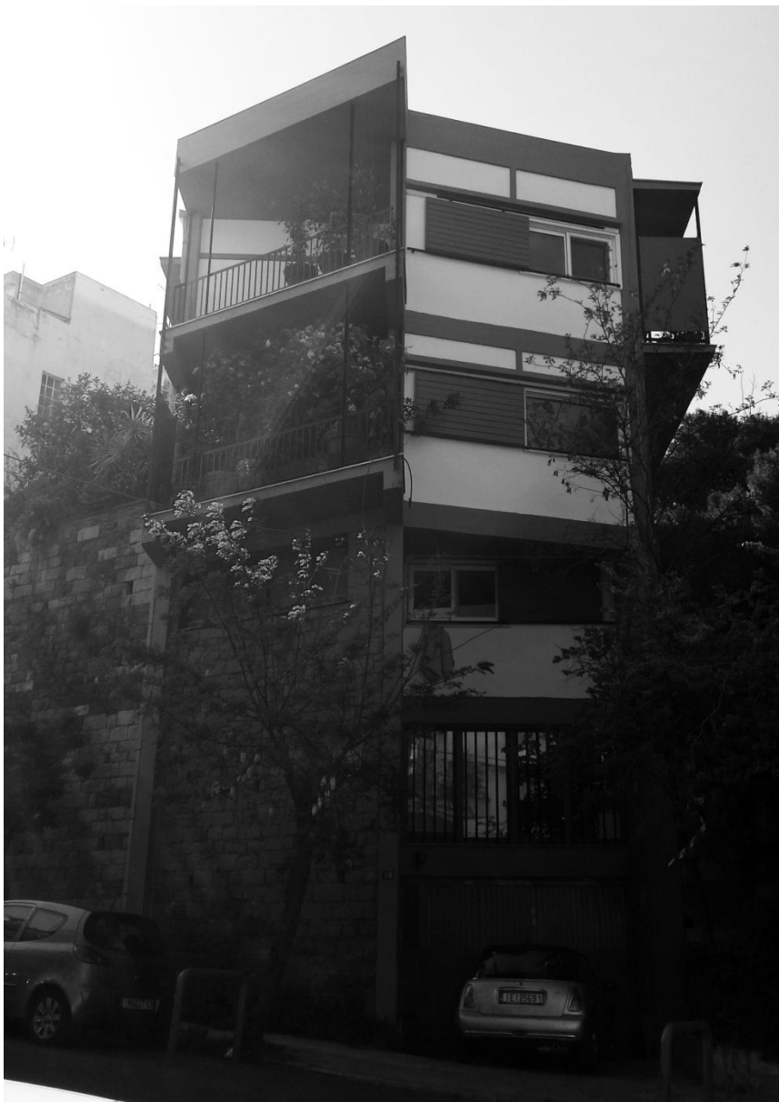
Εικόνα 152: Κωνσταντινίδης, μονοκατοικία, Παγκράτι 1961, σημερινή κατάσταση
