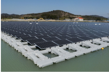
Εικόνα 41: Πλωτός σταθμός παραγωγής ηλιακής ενέργειας Higashihira Pond, Ιαπωνία
