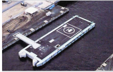
Εικόνα 39: Πλωτή βάση διάσωσης, κόλπος Ise Bay, Τόκυο
