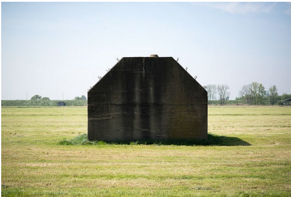
εικ. 22. Bunker της NDW
