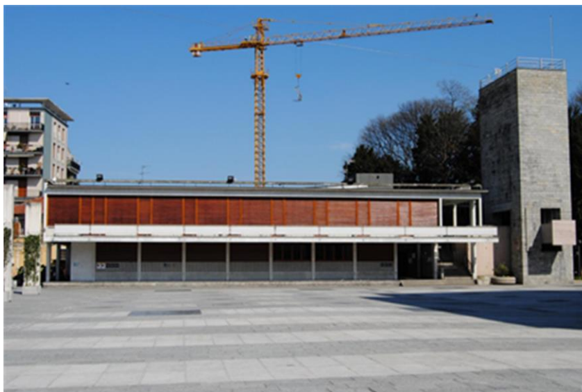
24.Casa del Fascio de Lissone, δυτική όψη
