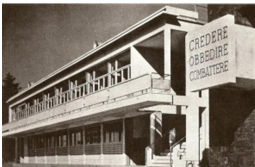
26.Casa del Fascio de Lissone, δυτική όψη
