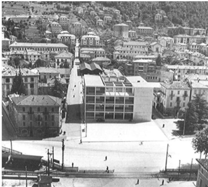
19.Casa del Fascio di Como,1940
