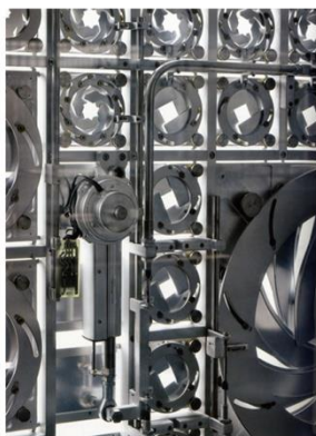
Εικ. 12: λεπτομέρεια μεταλλικών διαφραγμάτων
