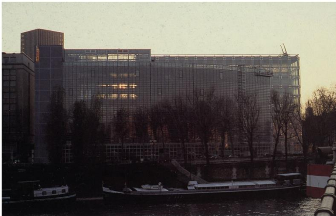
Εικ. 15: βόρεια όψη
