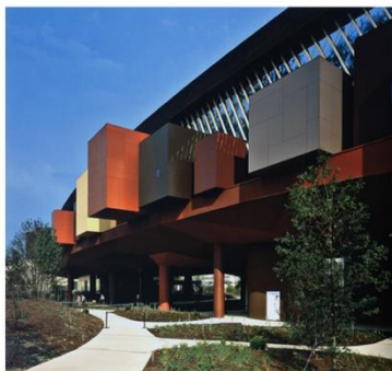
Εικ.7: βόρεια όψη - τα κουτιά που τοποθετούνται στο όριο της όψης και προεξέχουν από αυτήν επεκτείνονται το εσωτερ. έξω από αυτό το όριο
