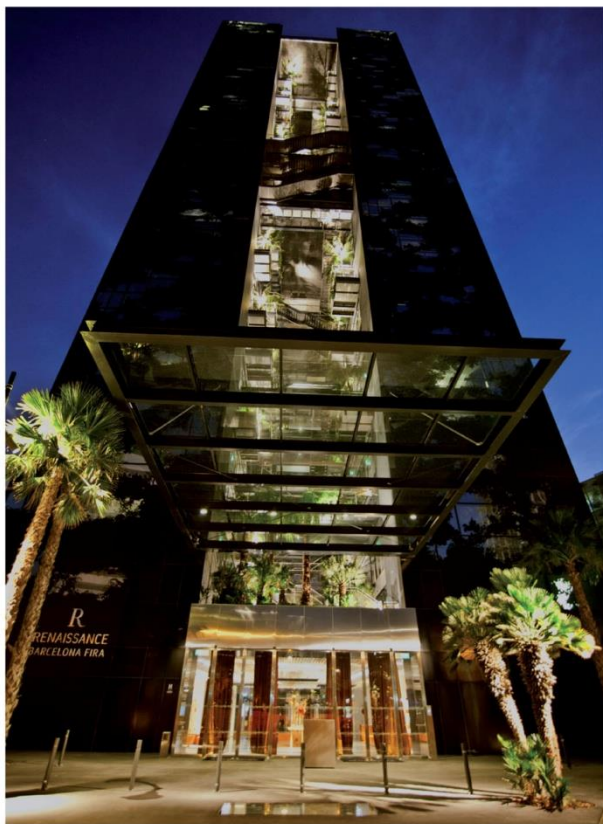
Εικ. 28: νότια όψη - είσοδος
