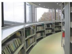
Εικ. 16: άποψη του εσωτερικού του 'πύργου των βιβλίων' ανοίγματα στην περιφέρεια ορίζουν το 'εσωτερικό όριο'
