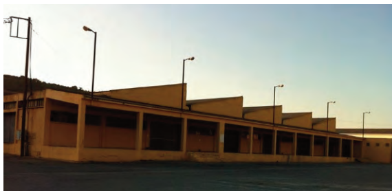
Εικ. 17-18: Χαρακτηριστικό παράδειγμα βιομηχανικού «οδοντωτού κτιρίου» οι αποθήκες του Αγροτικού Συνεταιρισμού Αρχανών.
