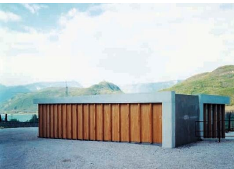
71. Το ξύλο χρησιμοποιείται για την πλήρωση του περιπτέρου
