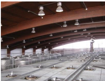
36. Χώρος πάνω από τις δεξαμενές
