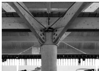
115. Υποστήλωμα που στηρίζει την ξύλινη στέγη
