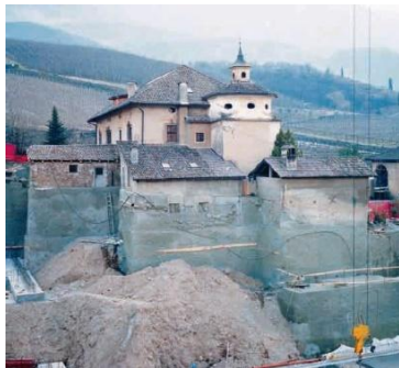
68. Εργασίες κατασκευής των νέων εγκαταστάσεων
