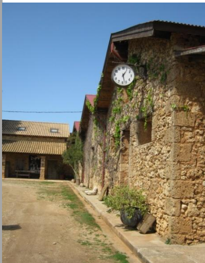
40. Όψη παλιών κτιρίων του Οινοποιείου
