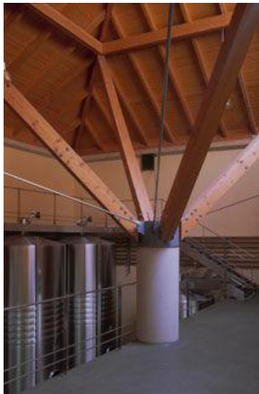
101. Υποστυλώματα που στηρίζουν την ξύλινη στέγη
