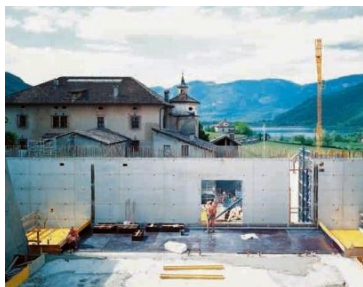
69. Οι σύγχρονες εγκαταστάσεις, από εμφανές σκυρόδεμα
