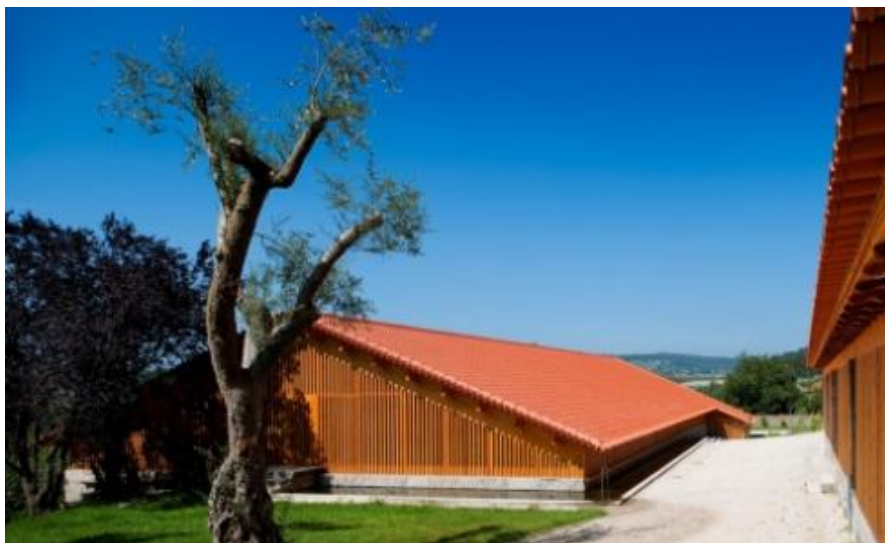
114. Το νέο κτίριο επιχωματωμένο στη νότια και δυτική πλευρά
