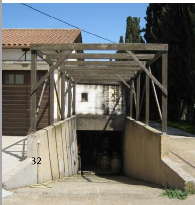
41. Όψη σύγχρονων κτιρίων του Οινοποιείου
