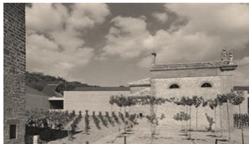
89. Όψη παλιών κτιρίων του οινοποιείου
