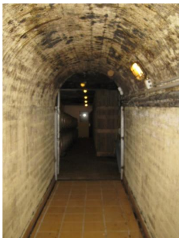
165. Επισκέψιμος υπόγειος χώρος όπου φυλάσσονται τα βαρέλια, κτήμα Μερκούρη
