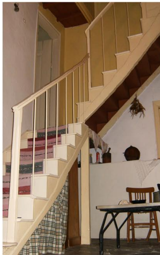
Εικόνα 26. Ξύλινη κλίμακα που οδηγεί στο μεσοπάτωμα (Λιτόχωρο)
