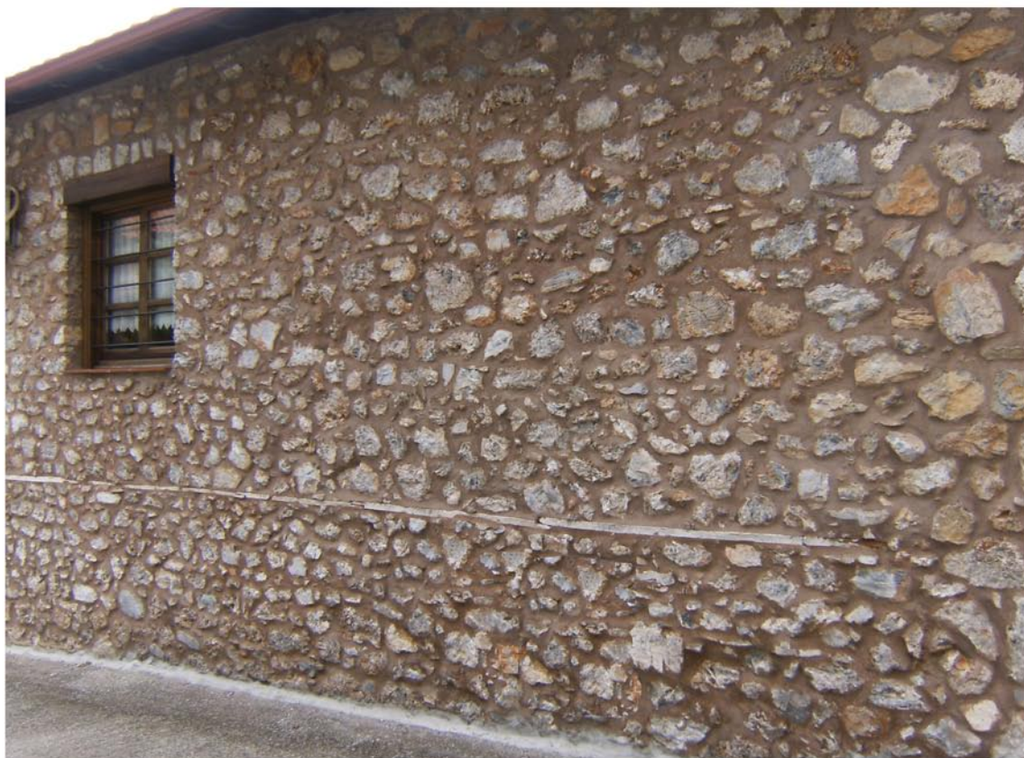
Εικόνα 17. Βόρεια πλευρά κατοικίας (Λιτόχωρο)
