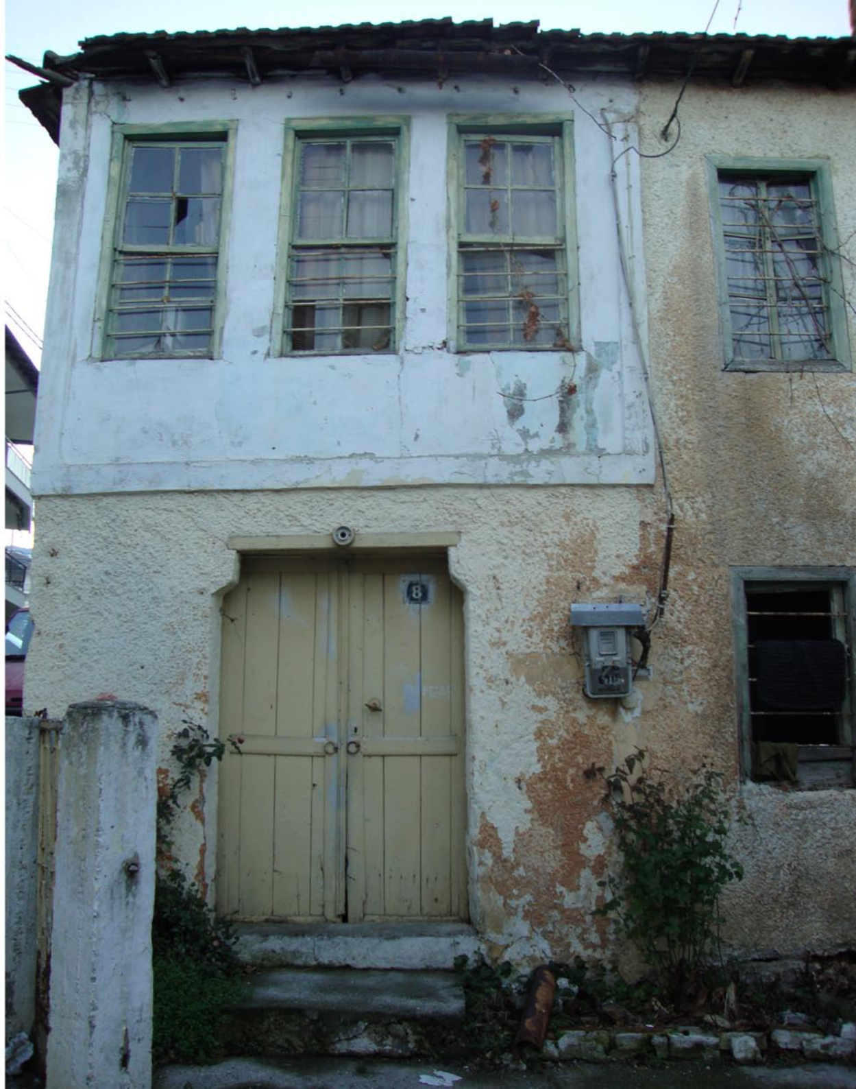
Εικόνα 29. Νότια όψη κατοικίας (Λιτόχωρο)
