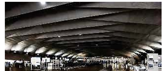
εικ.73, φέρον οργανισμός ως ενιαία, πτυχωτή πλάκα
