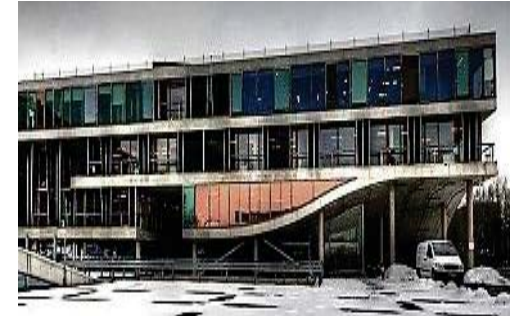
εικ.32, κτήριο γραφείων Villa VPRO, MVRDV
