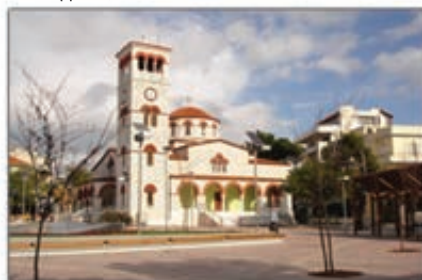
Εικόνα 2.3.3.1 Παλιότερη όψη της πλατείας Αναλήψεως 33
