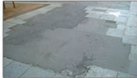
Εικόνα 7.2.2.1 Χρήση 'μπαλωμάτων' για την επιδιόρθωση του οδοστρώματος. 76
