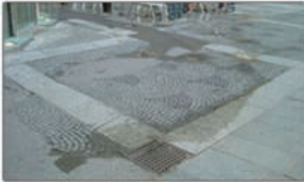
Εικόνα 7.2.2.1 Χρήση 'μπαλωμάτων' για την επιδιόρθωση του οδοστρώματος. 76
