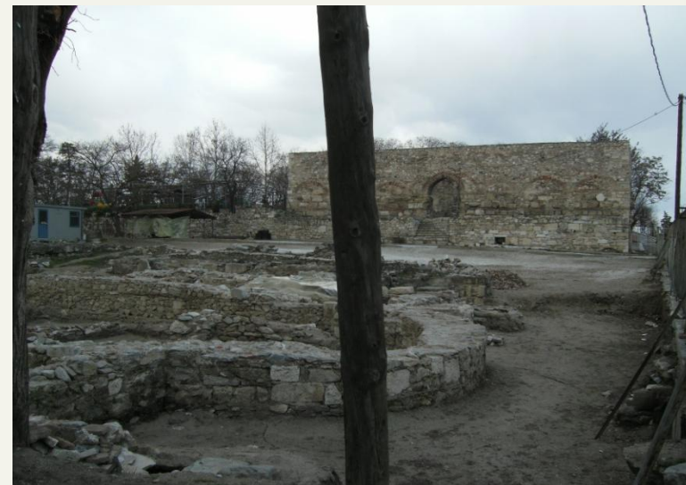
Εικ 69: Το μπεζεστένι κατά τις εργασίες αποκατάστασης (1 η Μαρτίου 2012), (Πηγή: προσωπικό αρχείο)
