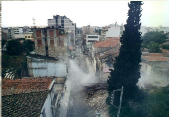
Εικ 28 : Έναρξη εργασιών κατεδάφισης απαλλοτρωμένων κτιρίων στο χώρο του αρχαίου θεάτρου, 1992
