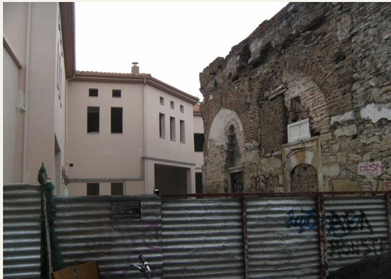
Εικ. 79: Ανεγερθείσα οικοδομή πλησίον του μνημείου (1 η Μαρτίου 2012), Πηγή : προσωπικό αρχείο
