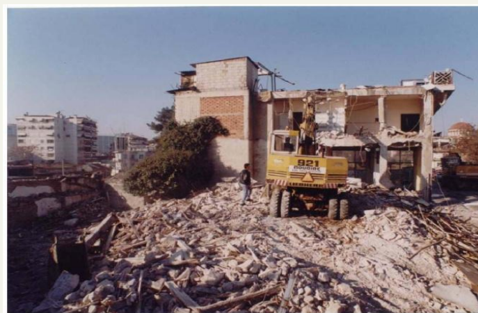
Εικ 36: Η κατεδάφιση κτιρίων της τρίτης φάσης κατεδαφίσεων, 1998
