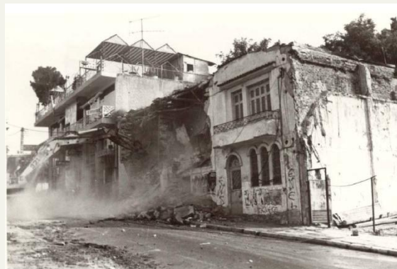
Εικ 31 : Κατεδάφιση επισκοπικού μεγάρου
