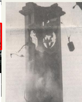
Εικ 116 : Το ρολόι προ κατεδάφισης / Το ρολόι κατεδαφίζεται
