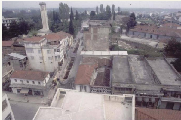
Εικ 26 : Διάνοιξη δοκιμαστικής τομής επί της οδού Παπαναστασίου, 1985
