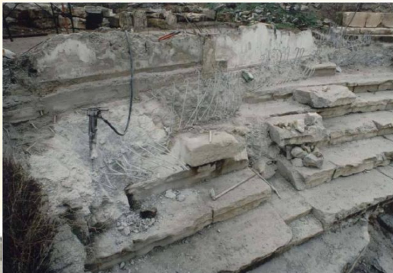
Εικ 25 : Κατεδάφιση οικοδομής Γκαράνη, Αποκάλυψη πρώτων κερκίδων
