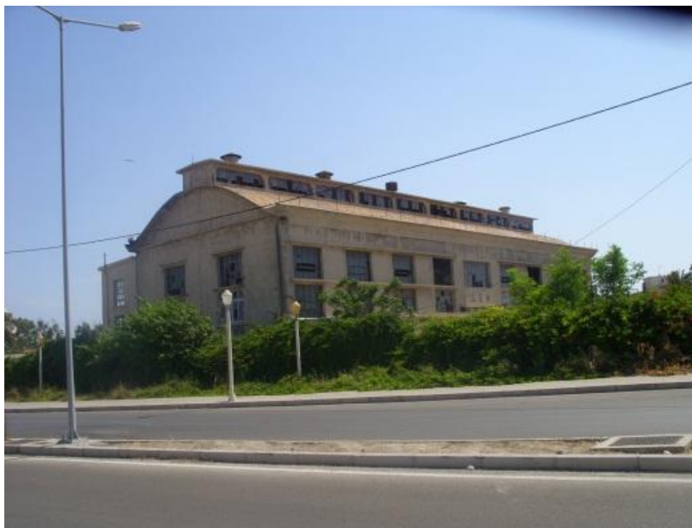
Εικόνα 25 Το εργοστάσιο στην περιοχή Κόβα. Άποψη από την οδό Αυστραλίας
