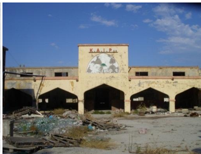
Εικόνα 48 Όψη του εργοστασίου
