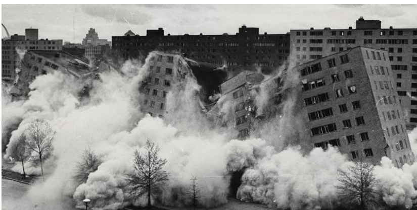
6| Κατεδάφιση του συγκροτήματος Pruitt-Igoe
