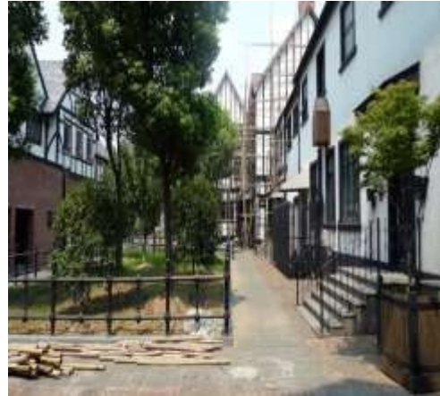
26. Εσωτερικός χώρος-αυλή-Οικοδομικού τετραγώνου
