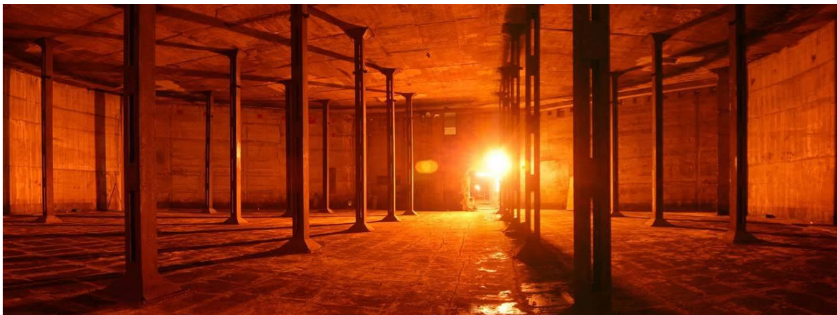
Εικόνα 3.7. Άποψη του χώρου των δεξαμενών μετά την αποκατάσταση. (Πηγή: ιστοσελίδα http://0.tqn.com/d/architecture/1/0/L/t/TateModernOilTanksSM.jpg )
