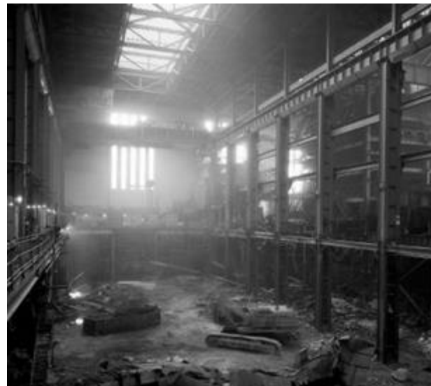
Εικόνα 3.5. Οι εργασίες για την μετατροπή της Turbine Hall σε εκθεσιακό χώρο της Tate Modern, 2003. (Πηγή: ιστοσελίδα
