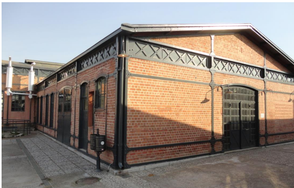
Εικόνα 2.19. Η είσοδος του Μουσείου Ύδρευσης. (Πηγή: ιστοσελίδα http://33dim.files.wordpress.com/2013/01/dsc034191.jpg )
