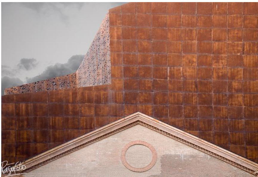
Εικόνα 3.19. Ο νέος όγκος πάνω από το παλιό τούβλινο κτίριο με την οξειδωμένη λαμαρίνα. (Πηγή: ιστοσελίδα
