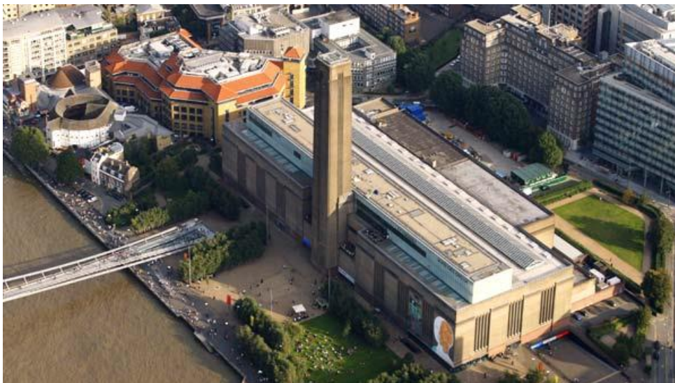
Εικόνα 3.11. Γενική άποψη της πινακοθήκης Tate Modern από ψηλά. (Πηγή: ιστοσελίδα http://www.e-architect.co.uk/images/jpgs/london/tate_modern_wa261108.jpg )
