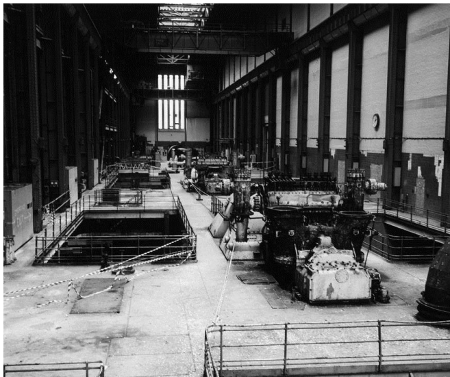
Εικόνα 3.4. Το εσωτερικό της Turbine Hall, 1995. (Πηγή: ιστοσελίδα
