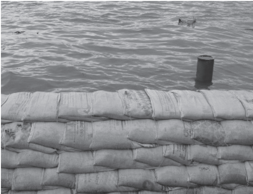
Πάνω: αντιπλημμυρικά μέτρα- σαλιά με άμμο. ηλεκτρονική πηγή: http://www.tankonyvtar.hu/bu/tartalom/tamop425/0032_vizgazdalkodas/cb06s02.html
