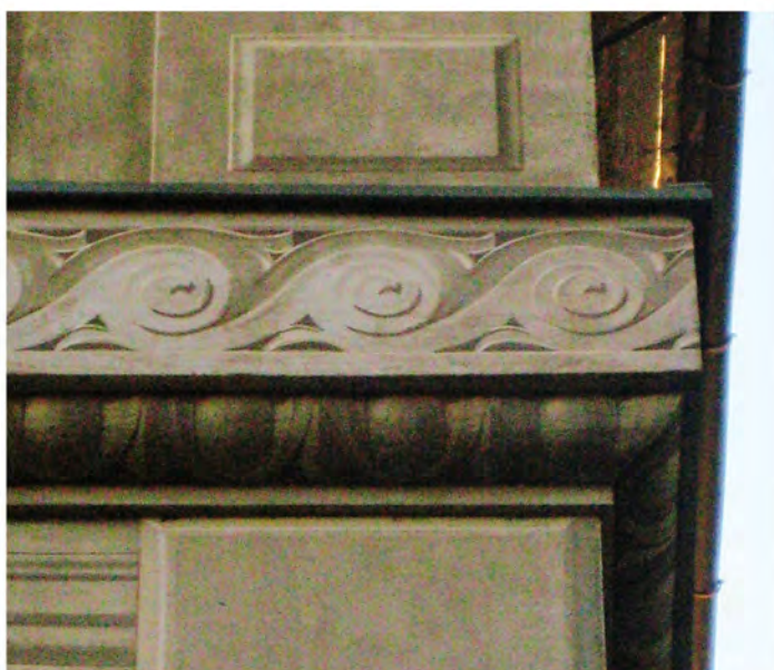
6. Γωνία του πρώτου ορόφου
