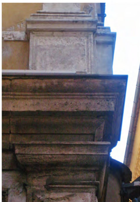
4.Γωνία του πρώτου ορόφου
