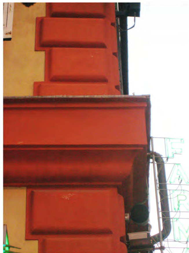
3.Γωνία του πρώτου ορόφου
