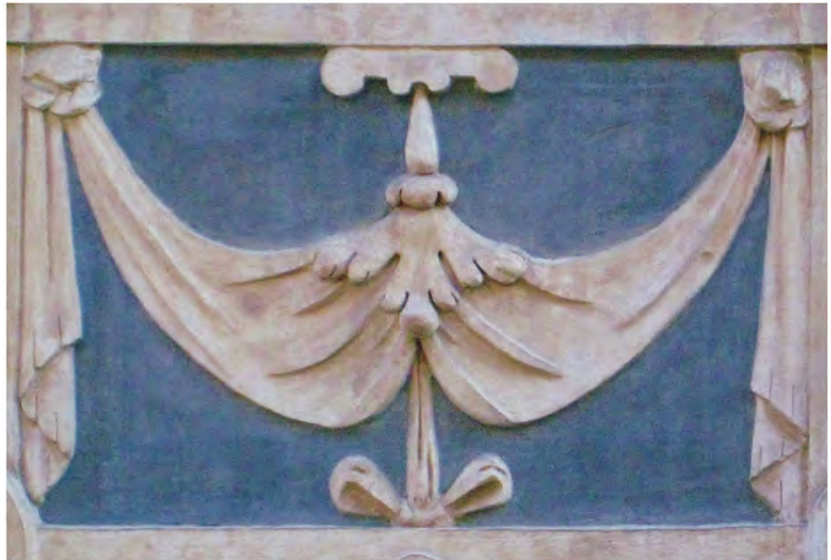
9. Γύψινη διακόσμηση του πρώτου ορόφου
