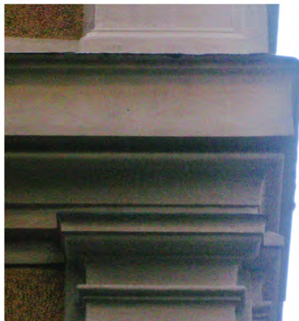
6. Γωνία του πρώτου ορόφου
