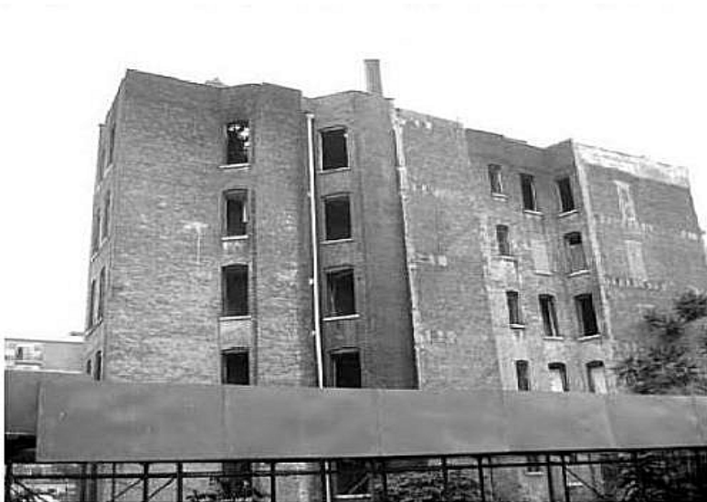
Εικόνα 25: Εγκαταλελειμμένο σπίτι στο Χάρλεμ, το οποίο πρόκειται να ανακαινισθεί. Πολλά κτίρια σαν αυτό έχουν ανακαινισθεί και τέτοιες ενέργειες συμβάλλουν στην γενικότερη αντίληψη ότι το Χάρλεμ βιώνει μια αναγέννηση.
