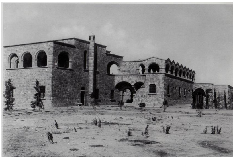
Εικόνα 44 Το Μοναστήρι της Παναγίας του Φιλήρημου μετά την αποκατάσταση-ανακατασκευή του (1931-33)
