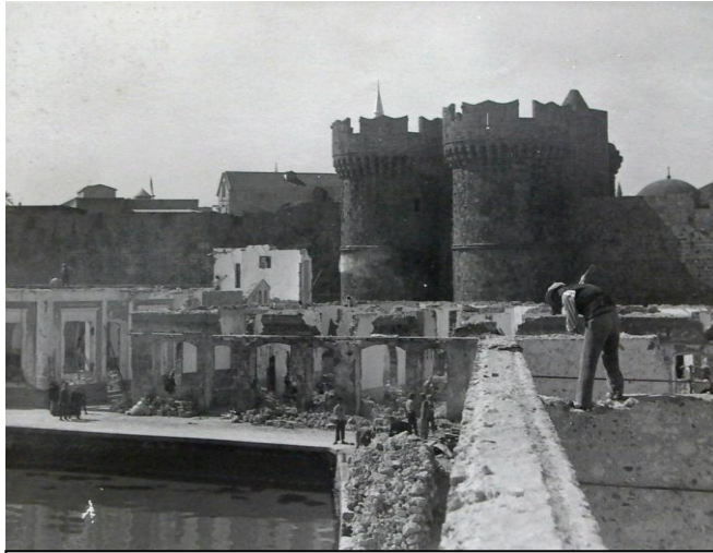
Εικόνα 19 Κατά τις εργασίες απελευθέρωσης της Θαλασσινής Πύλης από τα κτίσματα στο Ευποϊκό Λιμάνι (1934-35)
