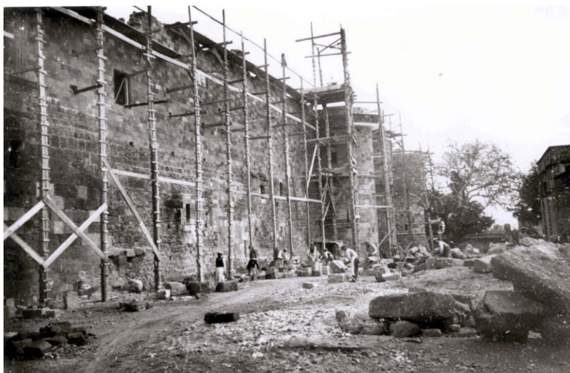
Εικόνα 30 Κατά τις εργασίες ανακατασκευής του Παλατιού του μ. μαγίστρου. Η νότια πρόσοψη (1937-40)
