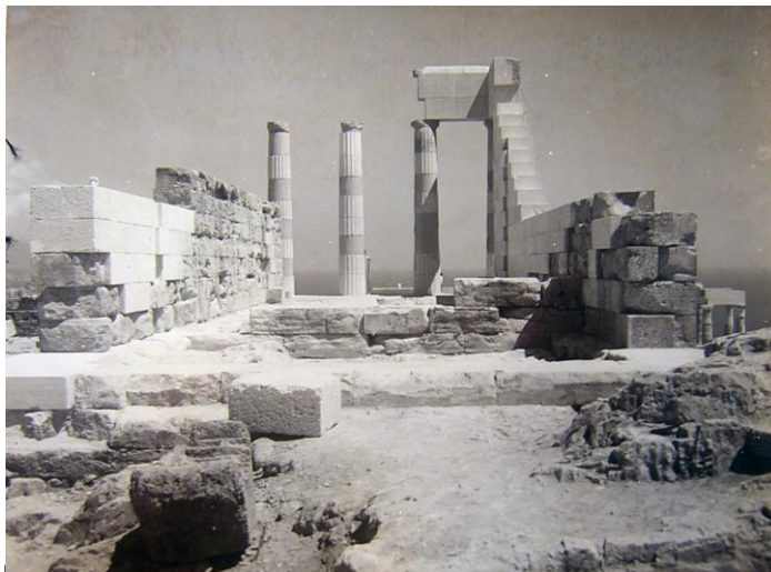
Εικόνα 32 Αποψη από Ν του Ναού της Λινδίας Αθηνάς μετά την αναστήλωση των τοίχων του σηκού και των κίωνων της βόρειας πρόστασης (1937-39)
