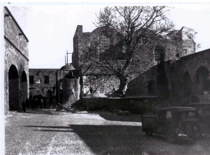
Εικόνα 35 Άποψη της Παναγίας του Κάστρου από την Πλατεία του Αρχαιολογικού Μουσείου κατά τις εργασίες αποκατάστασής της. Κατεδάφιση του μιναρέ (μετά το 1940)
