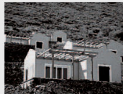
πάνω: Υποβάθμιση φυσικού περιβάλλοντος με διάσπαση όγκου σε πέντε (!) πανομοιότυπες κατασκευές εντός 4 στρεμμάτων (πρόθεση Νομοθέτη: ένας όγκος στο κέντρο της ιδιοκτησίας)
